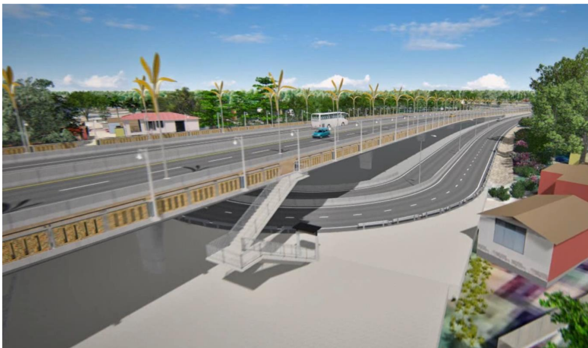
รูปที่ 2.2.1-12 รูปแบบจุดกลับรถใต้สะพานข้ามแม่น้ำปิง กม.1+652
